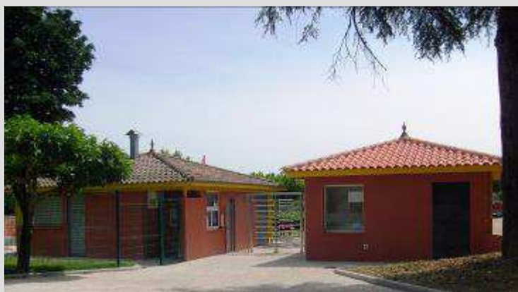
Aménagements de l'entrée du parc de loisirs
