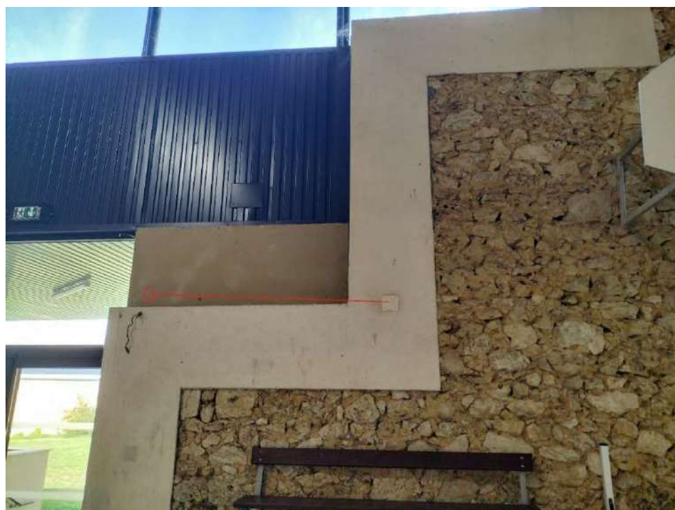
Cheminement de câble entre les onduleurs et l'intérieur du bâtiment (en rouge)
